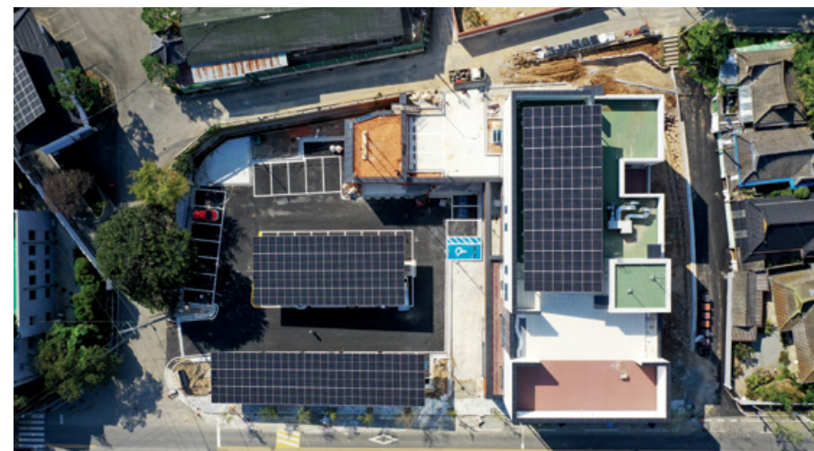
제로 에너지 건축물 2등급을 받은 영암지사 사옥에는 태양광 등 신재생에너지시설이 설치되어 에너지 절감을 이룬다.
